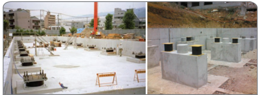
Şekil 95. Elastomer yalıtıcı uygulama örneği
