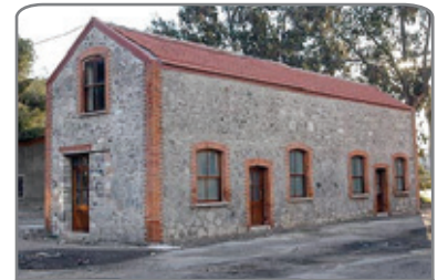
Şekil 12. Yığma duvarlı taşıyıcı sistem
