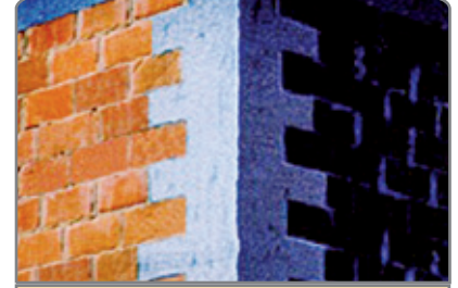
Şekil 51. Birbirine dik bağlanan taşıyıcı duvarların birleşimi
