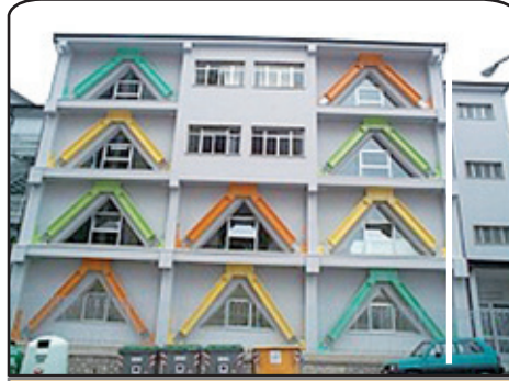
Şekil 97. Çelik çapraz uygulaması
