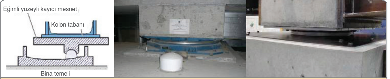
Şekil 96. Eğimli yüzeyli sürtünmeli yalıtıcı uygulama
