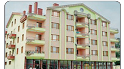
Şekil 29. Sıkça uygulanan giriş katında dolgu duvar bulunmayan konut
