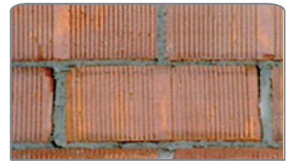
Şekil 58. Şaşırtmalı olarak örülmüş, düşeyde ve yatayda harç uygulanmış taşıyıcı duvar
