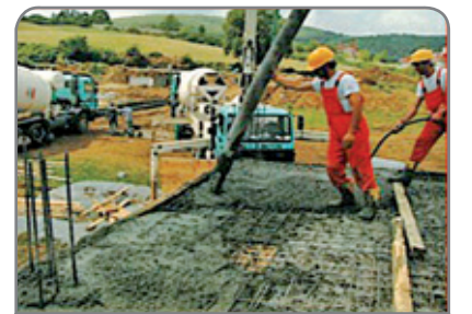
Şekil 39. Hazır beton santralinden gelen beton ile üretim
