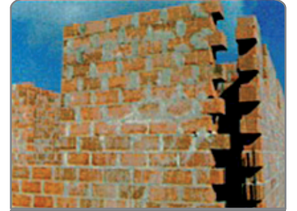
Şekil 56. Düşey hatıl boşluğu
