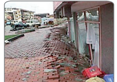
Şekil 23. Sıvılaşma sonucu meydana gelen zemin deformasyonu
