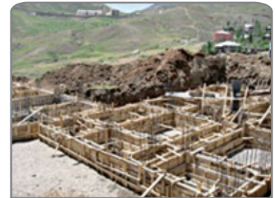
Şekil 18. Tekil temel ve sürekli temel örnekleri
