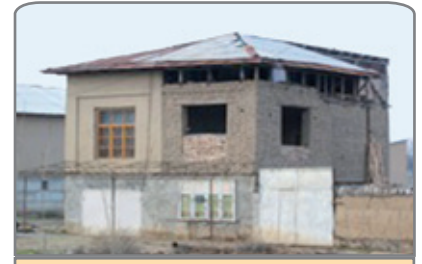
Şekil 53. Taşıyıcı duvarlarda sınırlanan değerden fazla açılan boşluklar
