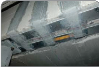
Şekil 65. Çelik levhalar ile kiriş güçlendirmesi-2
