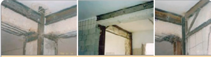
Şekil 64. Çelik profiller ile kiriş güçlendirmesi
