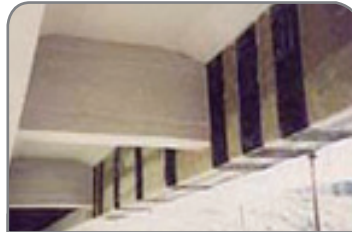
Şekil 66. Lifli polimer sargılar ile kiriş güçlendirmesi
