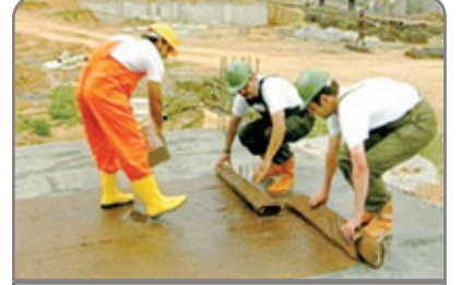
Şekil 40. Betonun nemli kumaşlar ile ıslak kalmasının sağlanması
