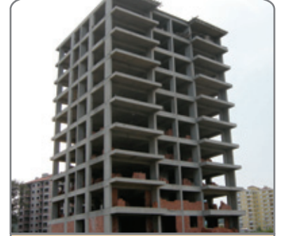
Şekil 10. Betonarme çerçeve taşıyıcı sistem
