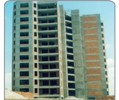
Şekil 11. Betonarme perde-çerçeve taşıyıcı sistem
