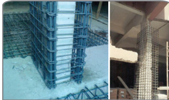
Şekil 75. Kolon mantolama örnekleri-3
