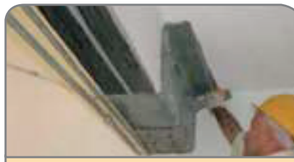
Şekil 67. Lifli polimer sargı ile çelik plakaların birlikte kullanılması
